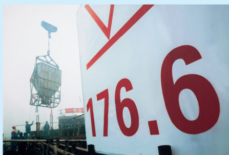
中线水源工程主体工程，经过6年多的加高培厚，大坝已由原来162米加高到176.6米，全线达到坝顶高程
