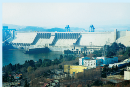
中线水源工程主体工程，经过6年多的加高培厚，大坝已由原来162米加高到176.6米，全线达到坝顶高程
