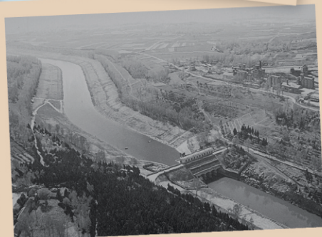
1974年4月，陶岔渠首建成，标志着丹江口水利枢纽初期工程全面竣工
