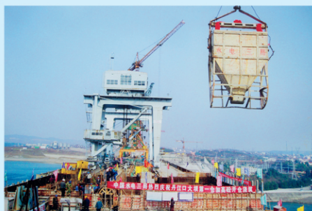
2005年11月25日，丹江口大坝加高第一仓混凝土开盘浇筑
