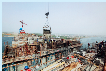
2009年4月20日，闸墩加高到顶
